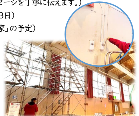
●体育館オペレーターを修繕し、ハンドルで窓を開閉できるように。換気を効率よく行えるようになります。
